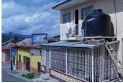
<Tanque(땅께)가 설치된 집>
